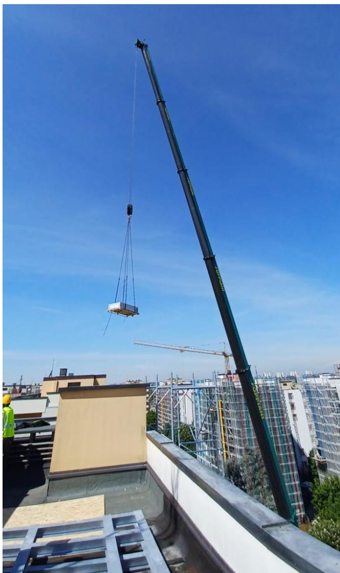
In copertura sono stati posizionati delle assi di legno a protezione della guaina
